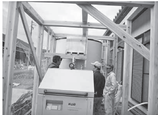
写真6 まきボイラーの施工の様子
