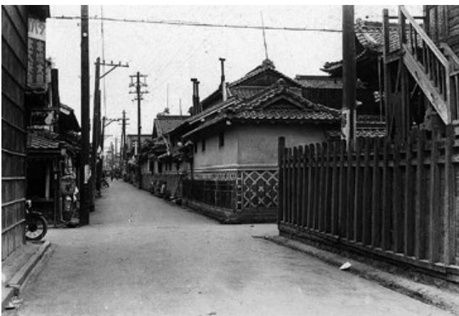
図 4. 広路線伏見町付近
