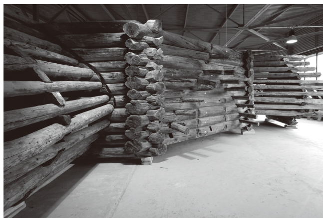
図5. 工房で修復中の壁面部材
