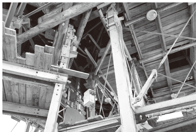
図4. 修復中の教会内部
