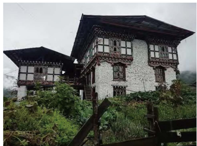
図-2 Bumthang 県 Tang 郡の住居建築
