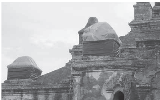
写真9 2016年の地震で被害を受けたダマヤンジー寺院 (シートで覆われている)
