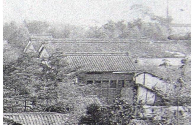
図 3 北方 倒壊を免れた土蔵群 (G. E. J)
