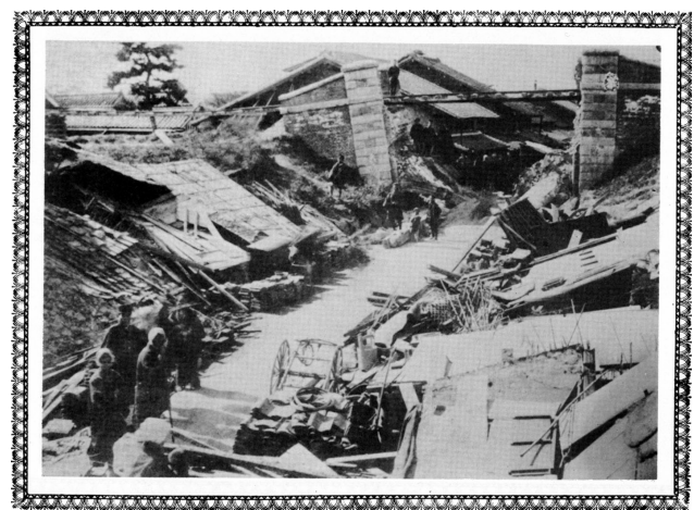
図／壊破チーフ道鐵町島杷枇西郡井日春西
