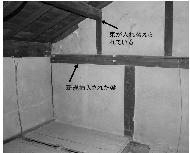
図13 旧堀田家住宅 東妻壁前面の小屋組の改変
