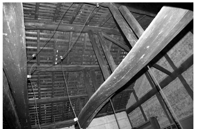
図 17 K 家住宅 土間小屋組 追補の大梁を副える
