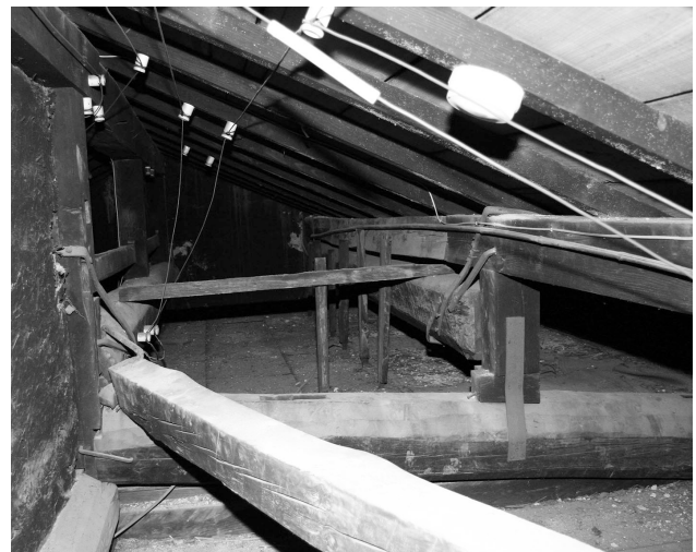
図14 旧堀田家住宅 前面小屋組 帯金物による補強
