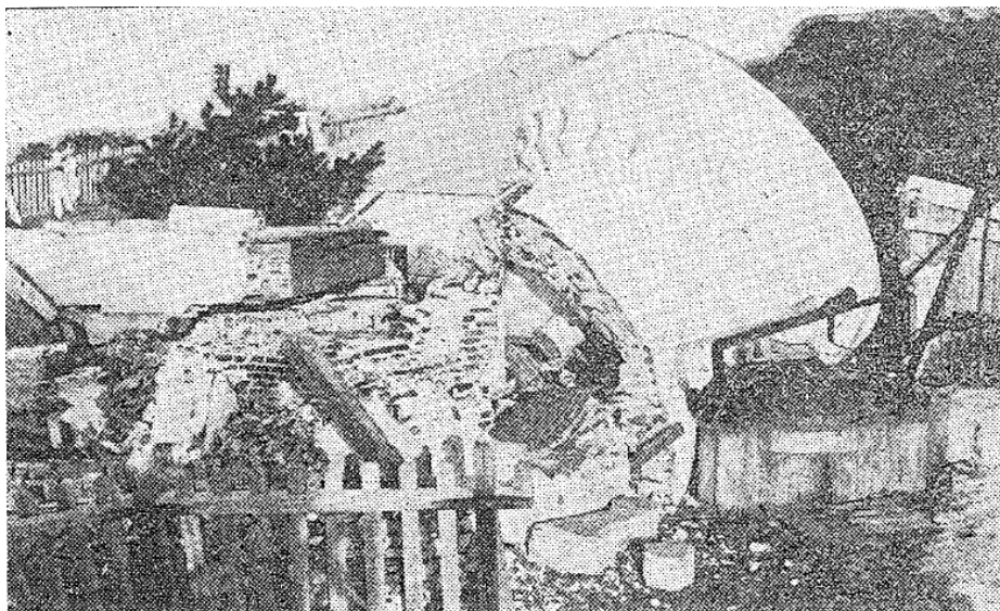
図 2-3 城ヶ島灯台（1923 年被災，煉瓦造）の被害状況 14)
