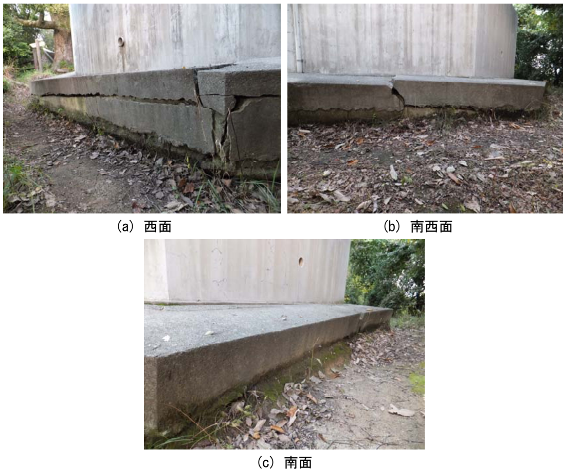
図 3-3 基礎部に生じたひび割れの状況
