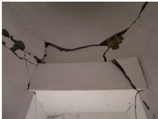
(b) 出入口上部の室内側の被害状況
