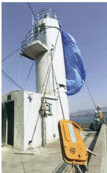
図 2-18 音戸灯台（2001 年被災，RC 造）の被害状況 20)
