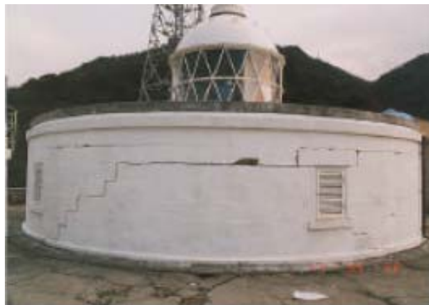
図 2-4 江崎灯台（1995 年被災，石造）の被害状況 18)
