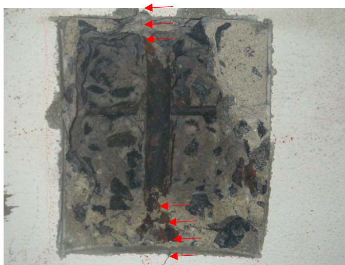
図10 比岐島灯台(No.23)のはつり調査箇所における鉄筋の腐食状況(腐食グレードV)とひび割れの状況
