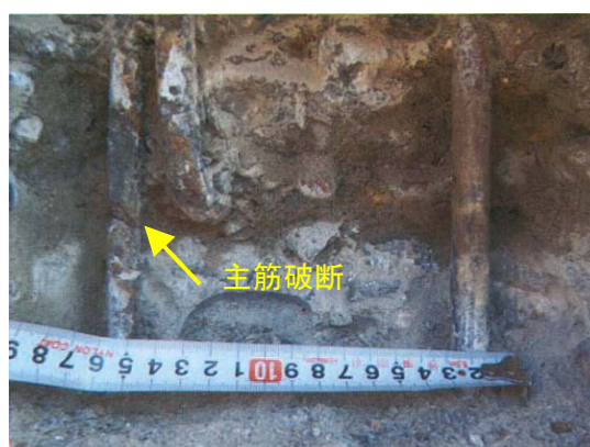
(c) (b)の青枠部分はつり調査結果
