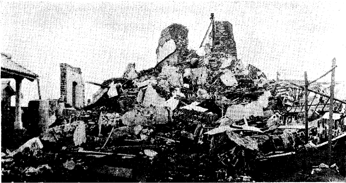
図 2-10 野島埼灯台（1923 年被災，煉瓦造）の被害状況（北側から撮影） 25)
