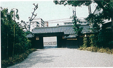
写真1-3 櫻明荘内から長屋門を見る。門内は砂利敷。
