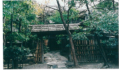
写真1-6 見付の庭の露地門。手前は延べ段で奥は飛び石になっている。
