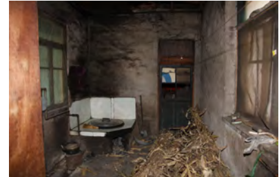
図 4 中央間背面の外屋地
