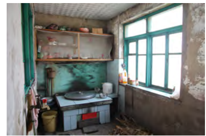
図 4 中央間背面の厨房の西向ビュー
