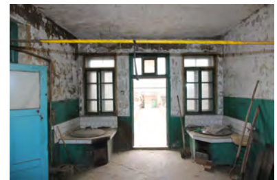
図 4 厨房の南向ビュー(竈)
