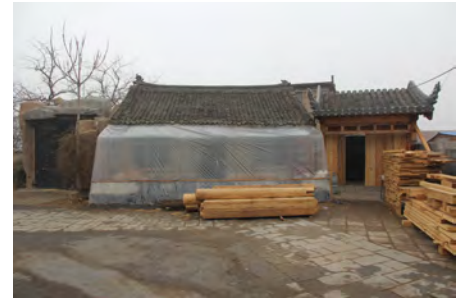
図2 街路から主屋北面ビュー
