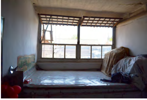
図 6 左脇ノ間の里头屋北から南を見る
