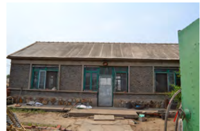
図 2 敷地門から主屋北外観ビュー(2012. 9)
