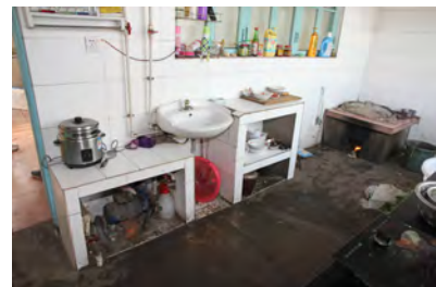
図5 中央間背面の厨房ビュー
