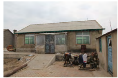
図2 主屋北側外観
