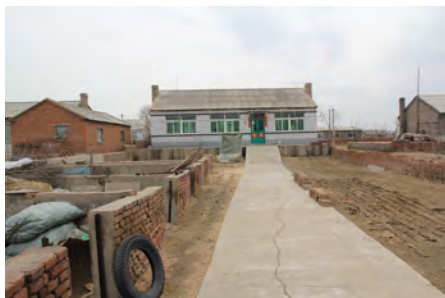
図3 敷地門から主屋北外観ビュー
