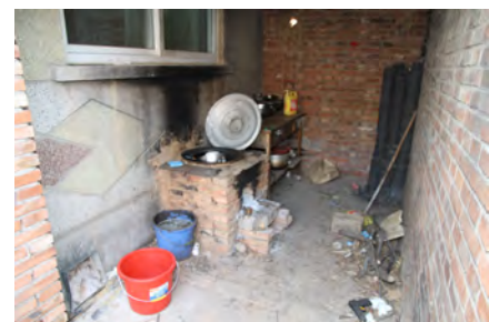
図 6 左間の炕に加熱する外付き竈
