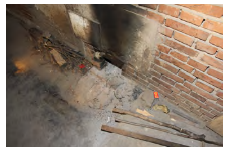
図 6 左脇ノ間の厨房の焚き口
