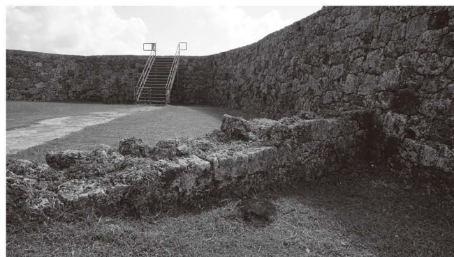
図-8. 城壁から伸びる袖壁
